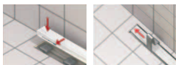
Instalación de la rejilla lineal antirrobo
